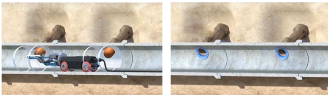
Figura 6: Esempio di illustrazione del funzionamento del sistema “Verpress- un Schalungssystem”
