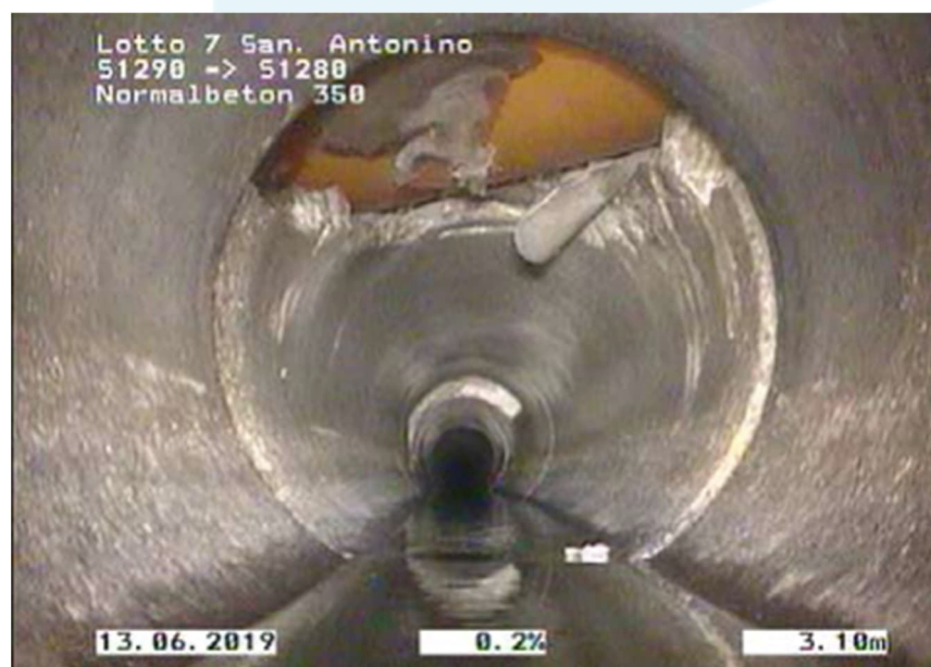
Figura 4: Rottura in calotta tra pz. S1290 – S1280
