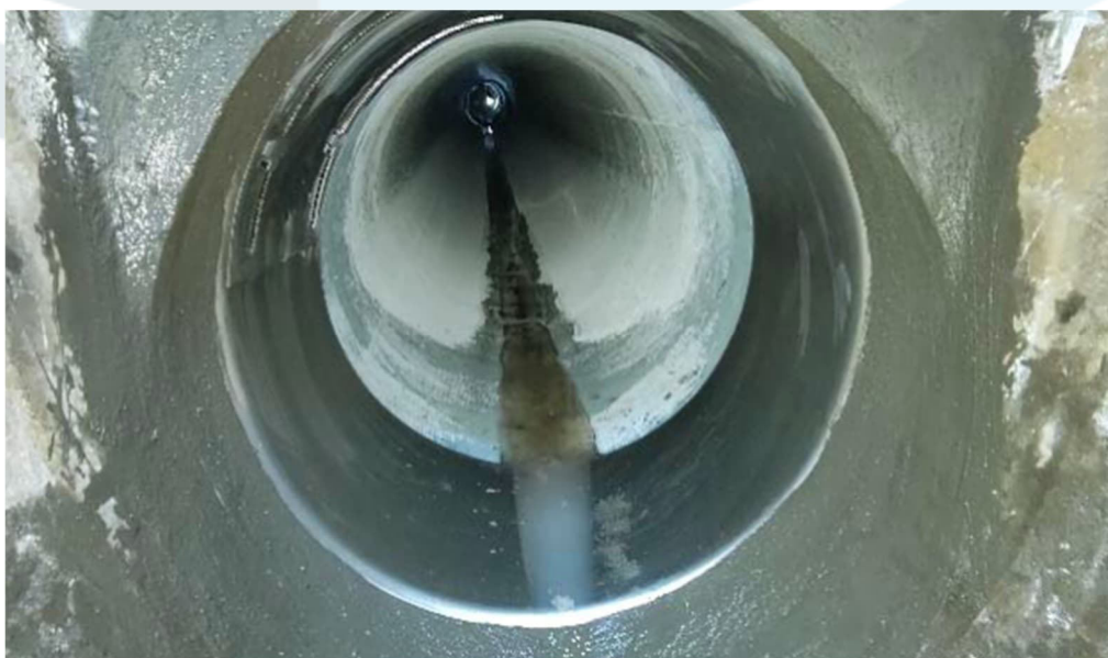
Figura 4: Esempio di manicotto autobloccante raccordo liner pozzetto
